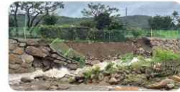
하천 제방 유실
